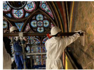
Notre-Dame de Paris / 2023 Dépose-repose des œuvres des chapelles pour restauration. Jean-Baptiste Jouvenet.
